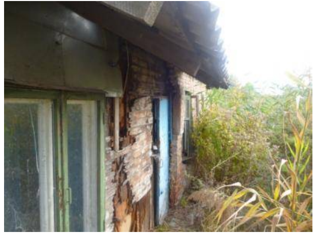
Нежитлова будівля контори літ. «А-1»
