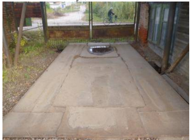
Нежитлова будівля вагової літ. «Б»
