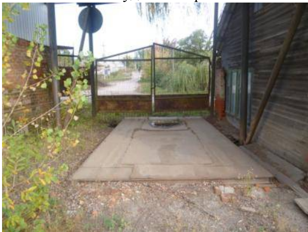
Нежитлова будівля вагової літ. «Б»
