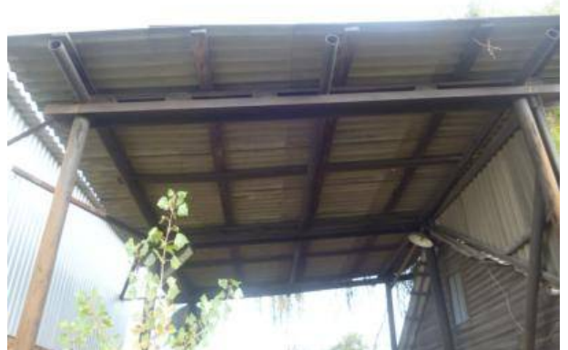
Нежитлова будівля вагової літ. «Б»
