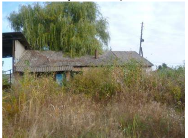
Нежитлова будівля контори літ. «А-1»
