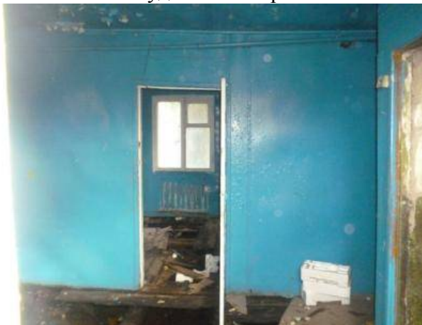
Нежитлова будівля контори літ. «А-1»
