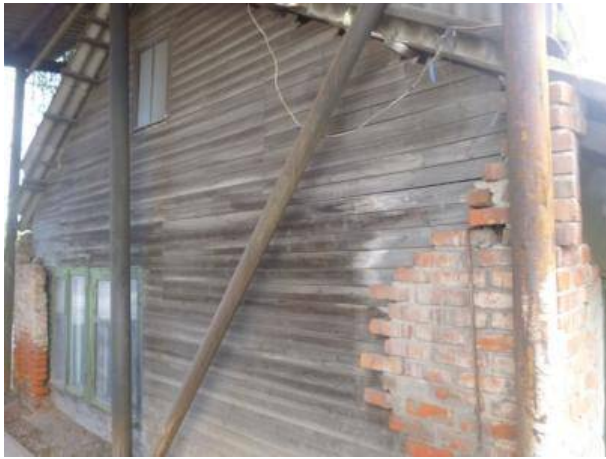
Нежитлова будівля контори літ. «А-1»
